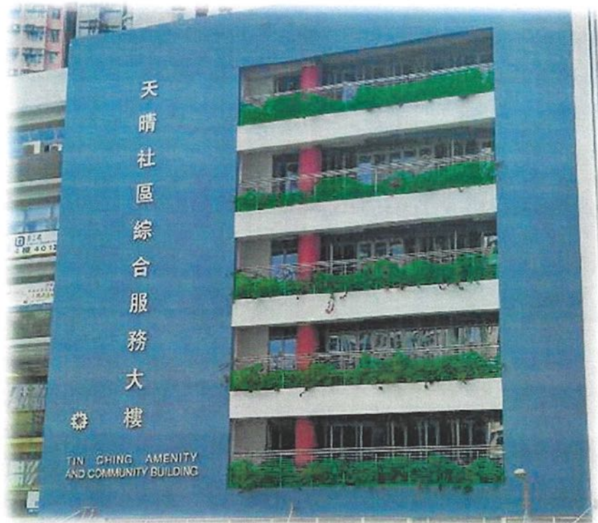
香港房屋署 天水圍 天晴社區大樓 陽台綠化工程, 完工12個月后外觀 (2013年3月)
